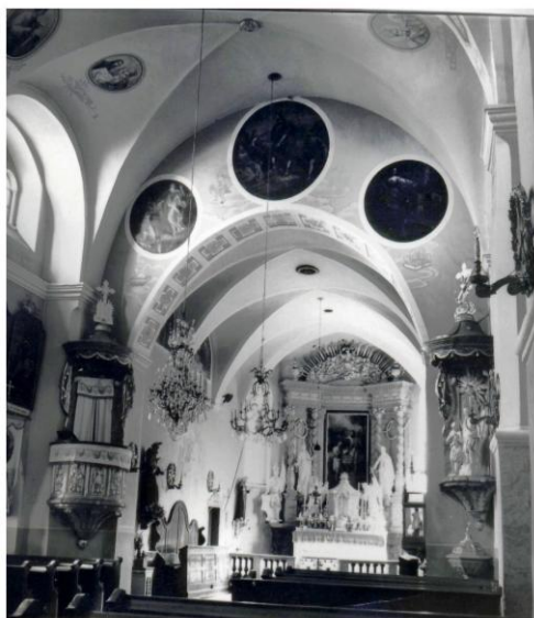
Interiér kostela padesátá léta 20. století
